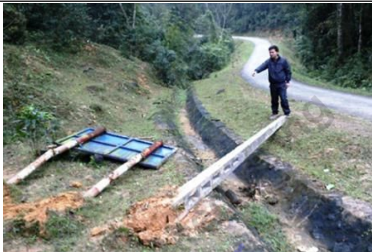
Voi rừng quật đổ cột điện
